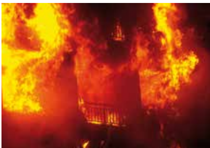
Abb. 1: Schrecken mitten in der Nacht: Brand der WDVS-Fassade in Berlin-Pankow, April 2005
