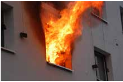
Abb. 1: Brand aus einem Raum des Gebäudes mit Beaufschlagung der Fassade durch Feuer nach Versagen des Fensters (Raumbrand)
