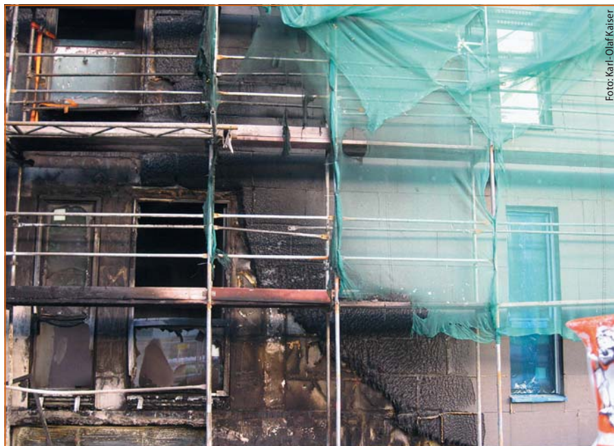
Abb. 2: Zerstörtes WDVS: nach dem Fassadenbrand auf einer Frankfurter Baustelle
